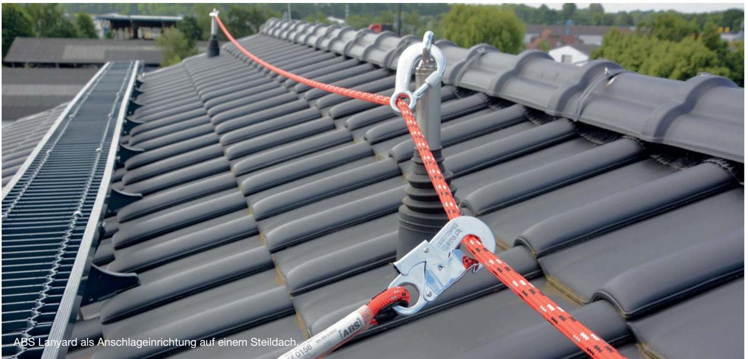
ABS Lanyard als Anschlageinrichtung auf einem Steildach
